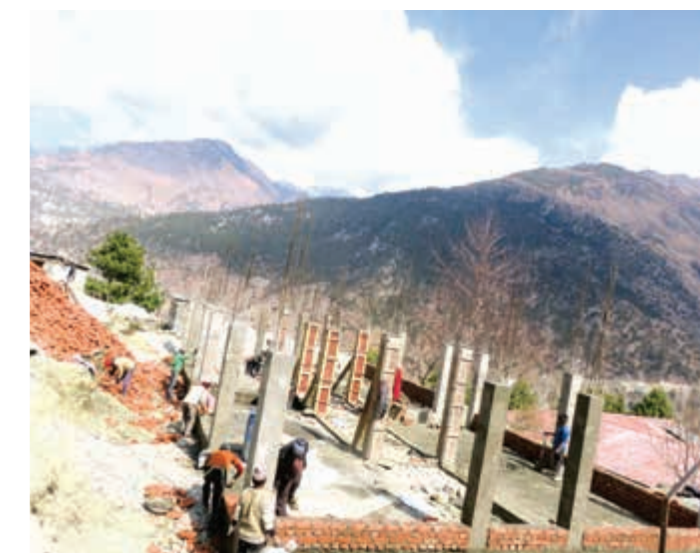
Der Neubau des Gebäudes schreitet voran und die Vorfreude wächst.
