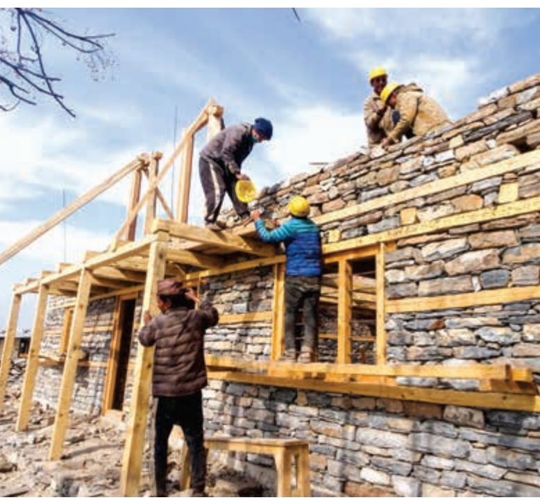
Die Bauarbeiter nutzen beim Bau der Dumana Schule ausschließlich lokale Materialien für die traditionelle Bauweise.
